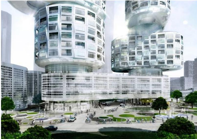
Velo塔楼由三个主要部分组成：一个底座，两个堆叠的体量，一座空中连接桥。首先，底座连接着两座塔楼，为公园旁边的公寓提供了空间，下方还有一个有顶的停车区域。其次，堆叠的体量提供了花园，通过核心筒提供了开放式的烟囱，并在这座大型综合建筑内提供了分散于多个地方的社区空间。第三，高处的空中连接桥不仅在结构上连接着两座塔楼的核心筒，还提供了空中公共设施，住户在这里可以俯瞰首尔的景色。
