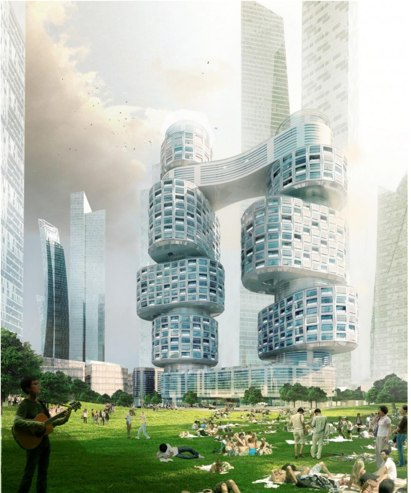
Asymptote建筑事务所设计的Velo塔楼是为韩国首尔龙山的总体规划设计的，由多个圆柱形的垂直体量组成，这些体量策略性地堆放在一起并经过旋转处理，不但使视野最大化、充分保护了隐私，而且使环境条件达到最佳。每座塔楼由八个不同的住宅部分组成，经过精心编排，与相邻的龙山公园和远处的汉江有着强烈的视觉联系。塔楼中设有一系列的屋顶花园、共享设施和内部交通流线空间，交通流线空间都围绕光线充足的开放式中庭设置
