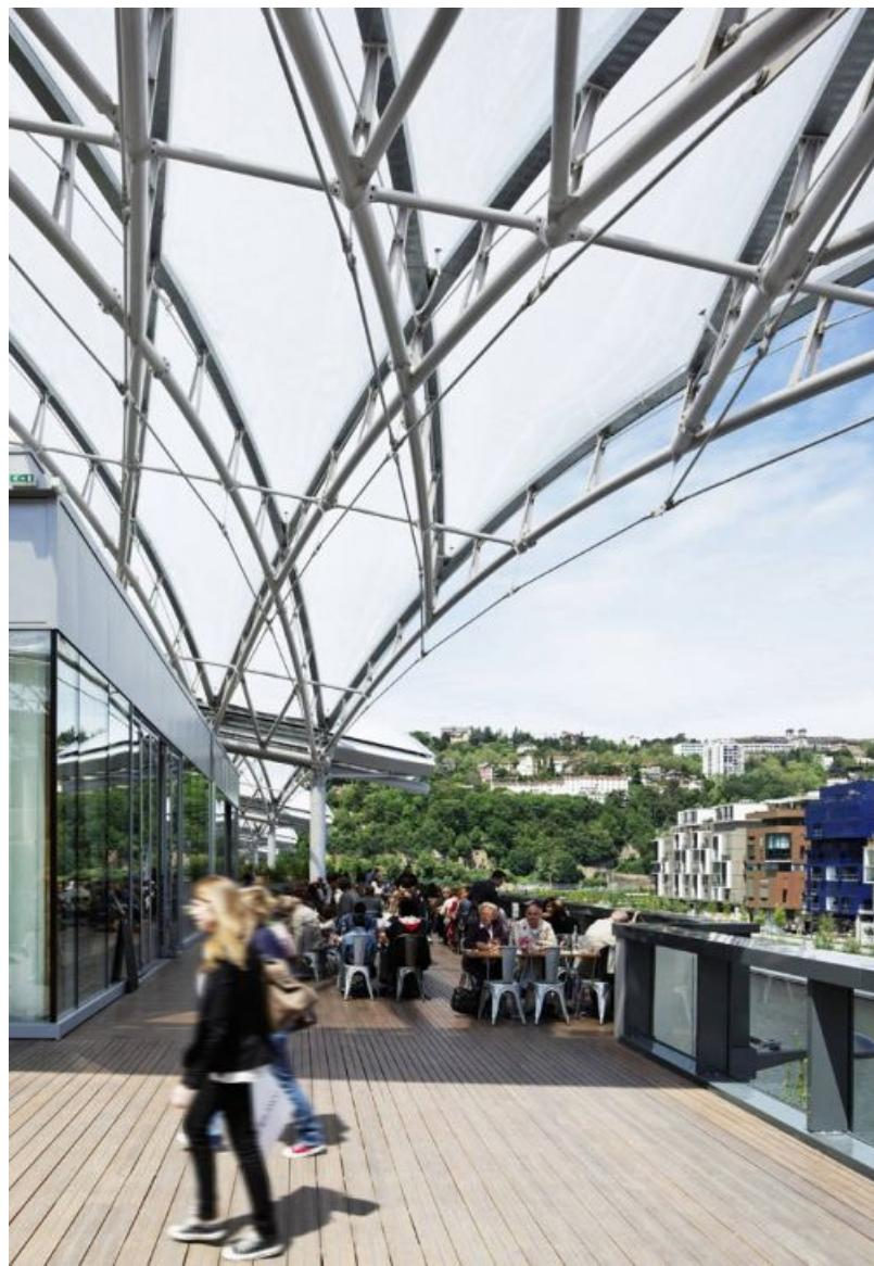
“商业娱乐中心的建设目标是成为里昂新区的标志性建筑，成为新时代的标志。这个多功能开发项目以其独特的屋顶与展馆式设计响应了雄心勃勃的设计目标。新中心的设计以带有高层露台、开放的主要室外展馆式结构组成，矗立在城市之中，创造了一个自然采光的大型空间。”为了能为这座城市创造一处前所未有的焦点地带，Jean-Paul Viguier为该项目构想了一种超越“经典”商业中心的设计概要。该建筑位于与索恩河相连的盆地边缘，透明的屋顶令大楼异常引人注目。这个透明屋顶由ETFE聚合物气垫构成，将整个场地统一起来，创造了一个特色非常显著的项目。建筑的四个楼层并排矗立在轻质屋顶下方。
